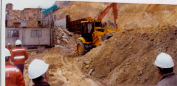
Contrato 095 de 2012. Estado de la Obra Sector El Porvenir - julio de 2013
